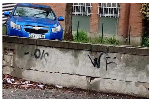
Fabrica de cerramiento degollada
